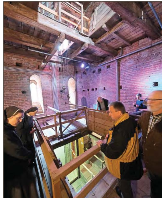
Blick nach unten ins Kirchenschiff von St. Jodok. Nach dem Zwischenstopp geht es im Kirchturm weiter gen Himmel.
