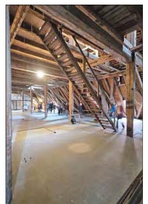
Ganz aufgeräumt, der Dachstuhl des Rathauses.
