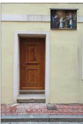
Die Renovierung des Hauses Kirchgasse 245: detailreich und kompetent.
